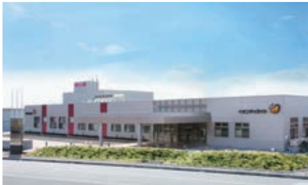
専門人材を育成するため電気・空調・給排水・消防設備など施設内環境を再現した独自の研究・研修施設「イオンディライトアカデミーながはま」(滋賀県長浜市)
