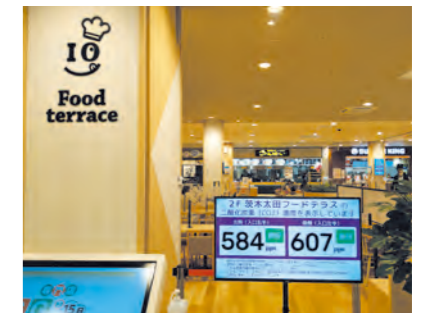
ネットワーク型CO 2 濃度モニターシステムの導入により換気改善を促進
